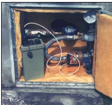
Fig. 121 - Installazione tipica dei contatori di prova volumetrici di classe D
